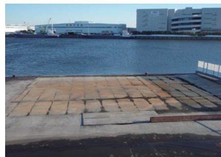
仮置き場D (汚染土壌用積出岸壁)
