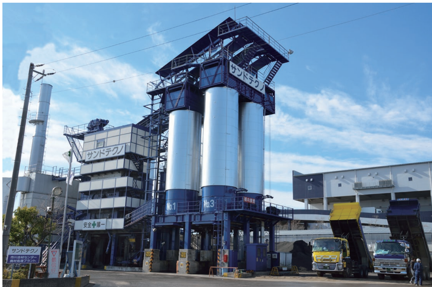
▲ アスファルト合材プラント
