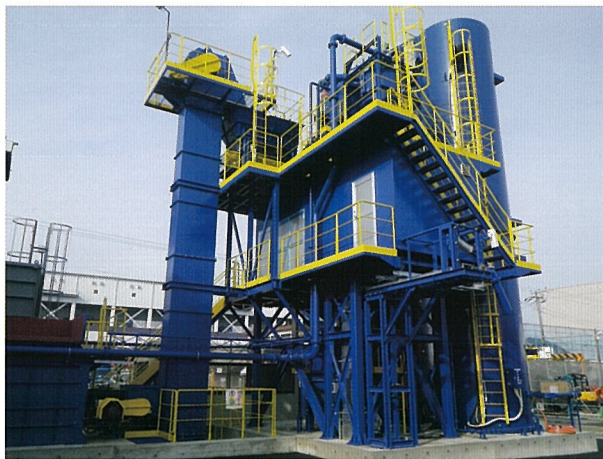
流動化処理土混合プラント（強制二軸型ミキサ）
