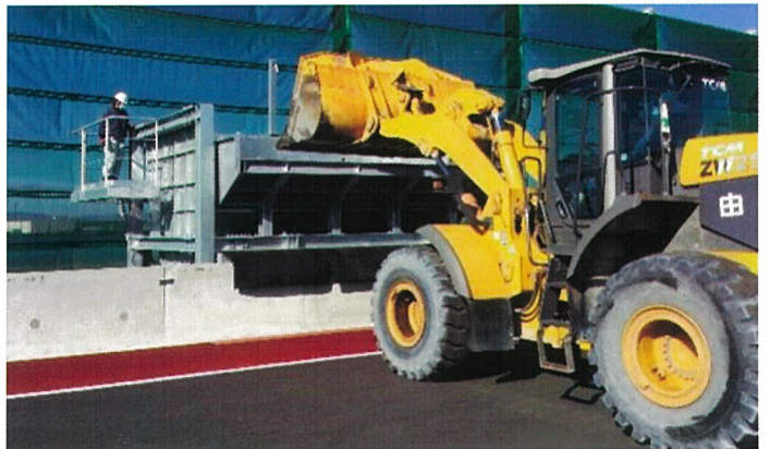
建設発生土の積出し(屋外)
